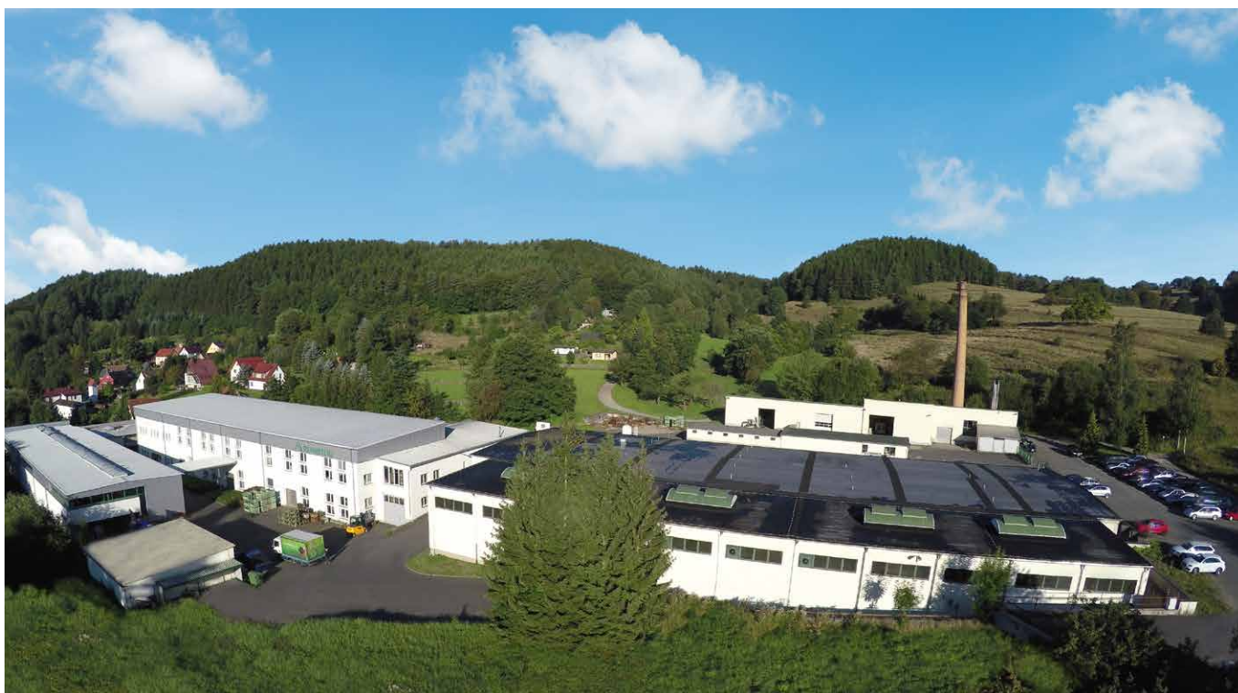
Betriebsteil Altersbach Manufacturing site Altersbach
